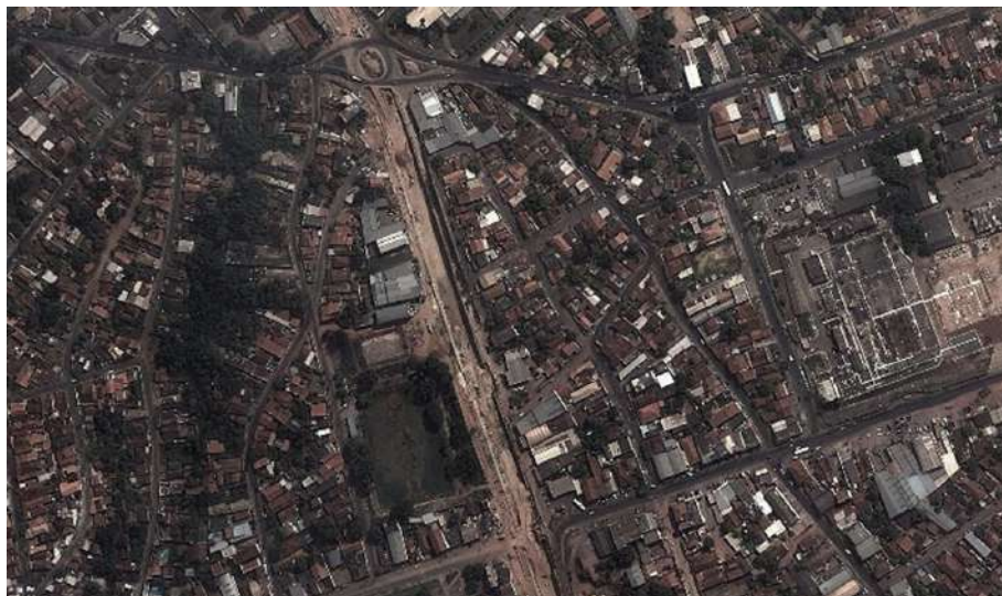
Figura 42 – Trincheira Jurumirim em construção, 2013
