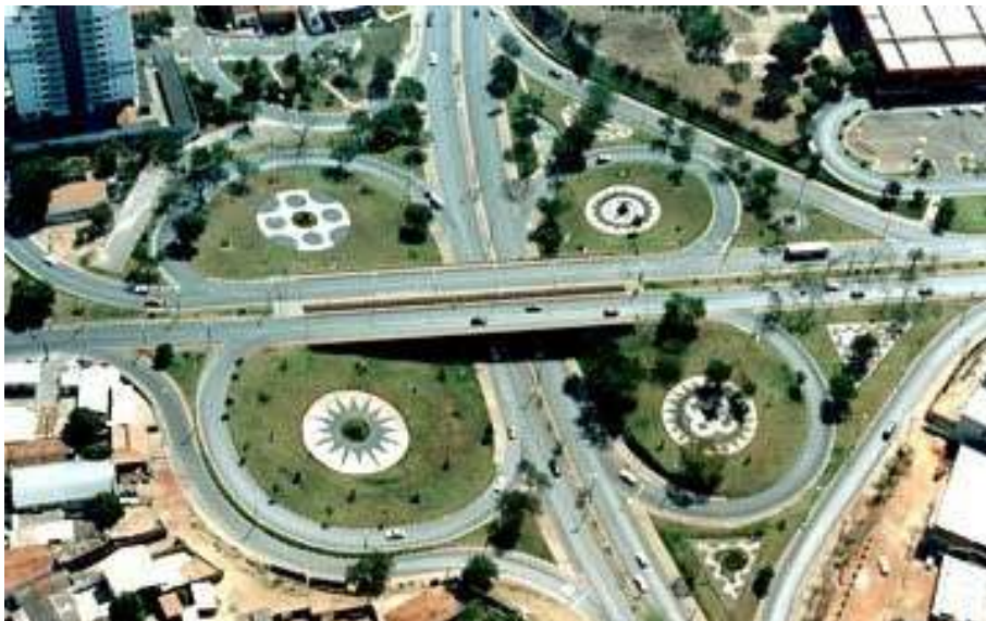
Figura 27 – Fotografia aérea do viaduto da rodoviária da cidade de Cuiabá (MT) em 2006
