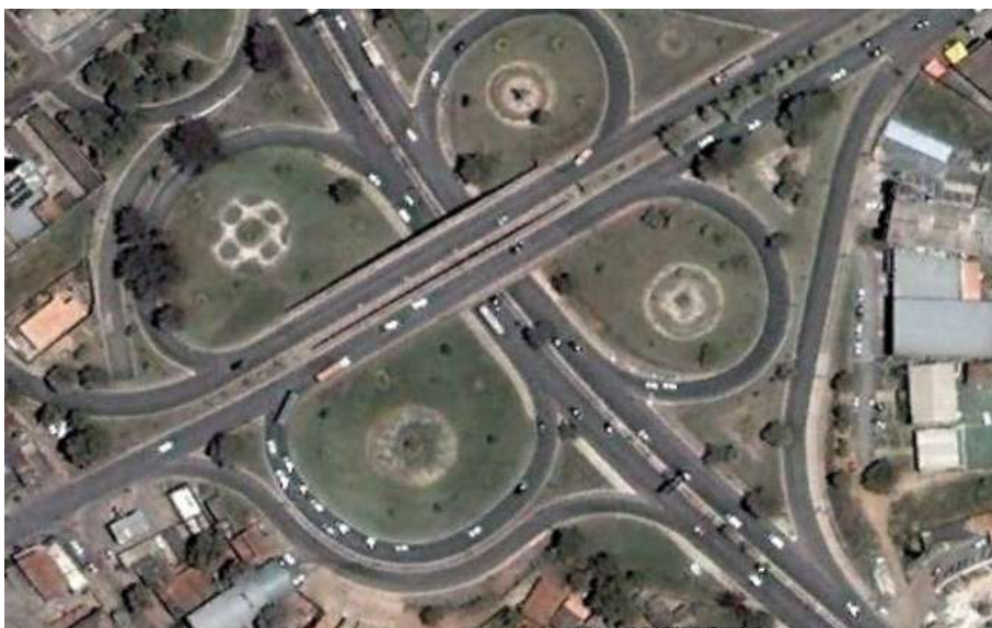
Figura 28 – Imagem do viaduto da rodoviária da cidade de Cuiabá (MT) em 2006
