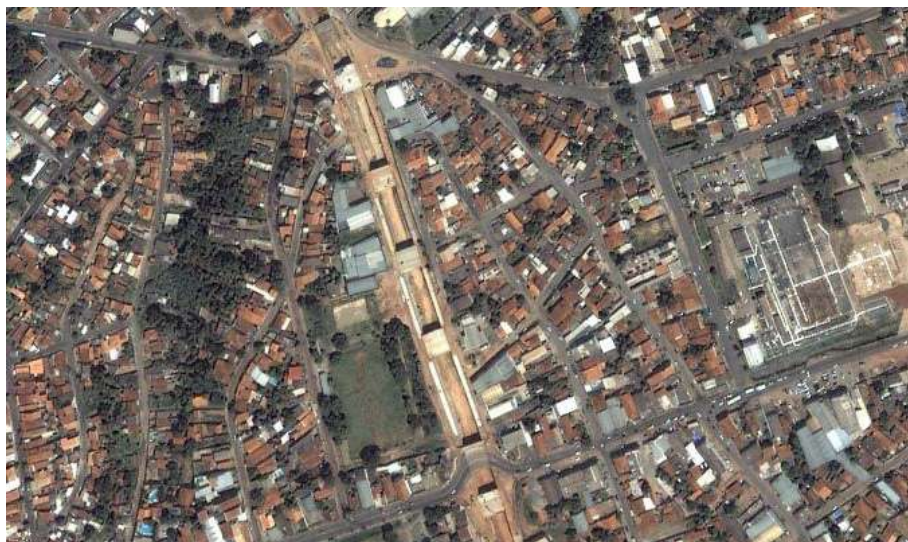
Figura 43 – Trincheira Jurumirim em construção, 2014
