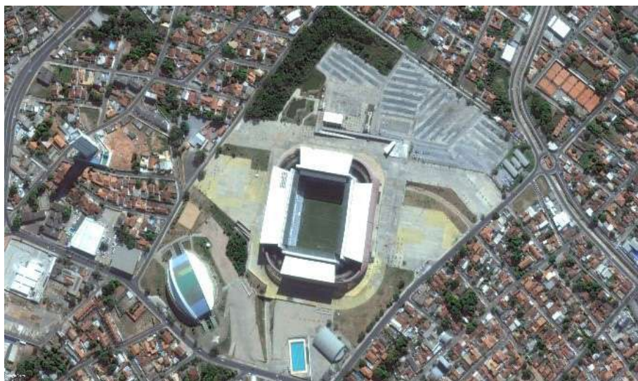
Figura 40 – Arena Pantanal finalizada, 2016
