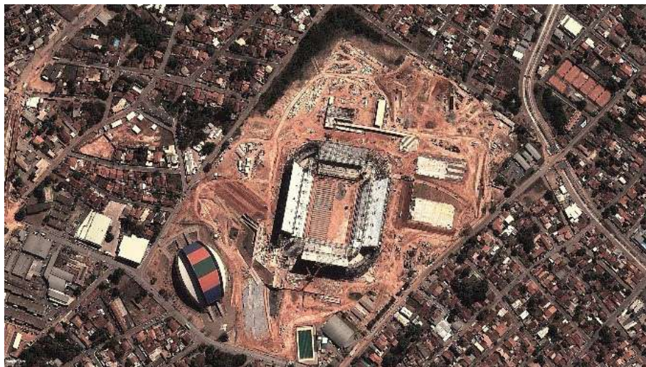
Figura 39 – Arena Pantanal em construção, 2013
