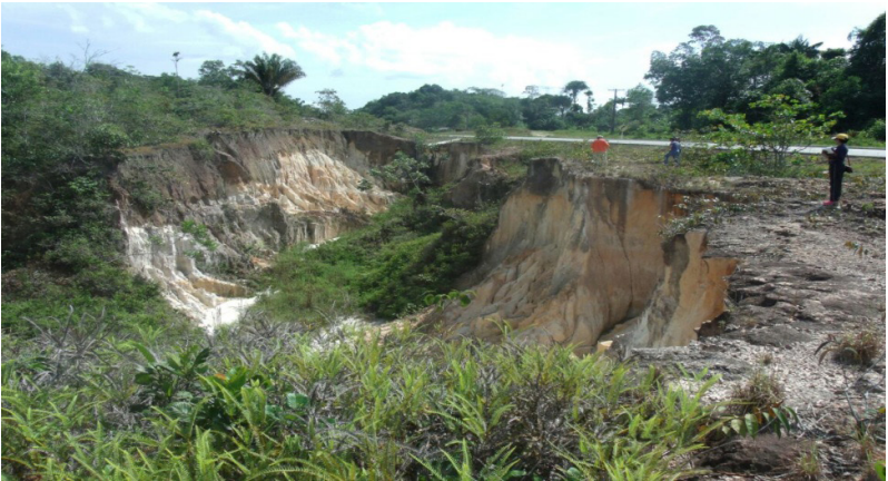
Figura 07: Voçoroca 10, km 37(B).
