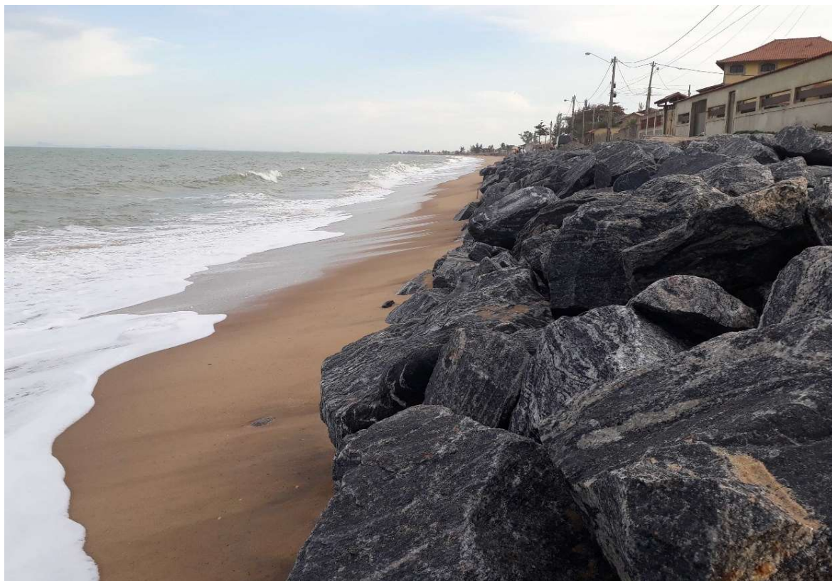
Figura 29.5. Estrutura longitudinal aderente à costa do tipo muro de enrocamento na Praia do Abricó, Rio das Ostras, RJ.
