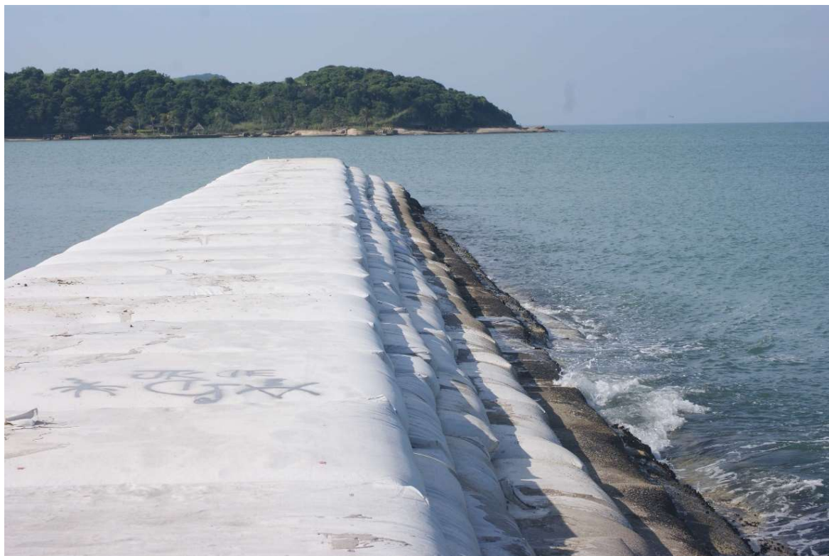
Figura 29.6. Espigão Guia-Corrente construído com geotêxteis ( geobags ) para interromper o transporte de sedimentos, fixar a embocadura de um canal e fornecer acesso à uma marina em Armação de Búzios, RJ.
