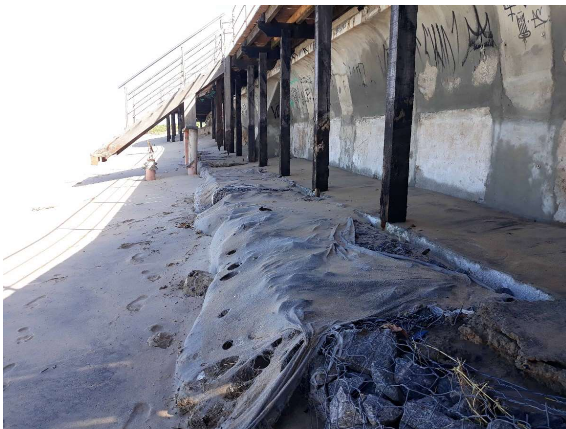
Figura 29.12. Exemplo de muro de gabião com concha defletora em concreto. Praia dos Cavaleiros, Macaé, RJ.
