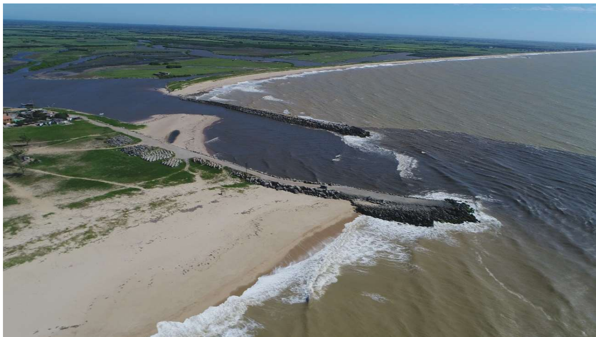
Figura 29.1. Assimetria na posição da linha de costa em resposta à construção de estruturas perpendiculares (espigões guia-corrente) em litoral com transporte de sedimentos de rumo dominante sul-norte. Barra do Furado, Quissamã, RJ. Tal assimetria chegou a 290 metros em 30 anos (Ribeiro et al., 2016) com taxas de acumulação ao sul semelhantes às taxas de erosão ao norte.
