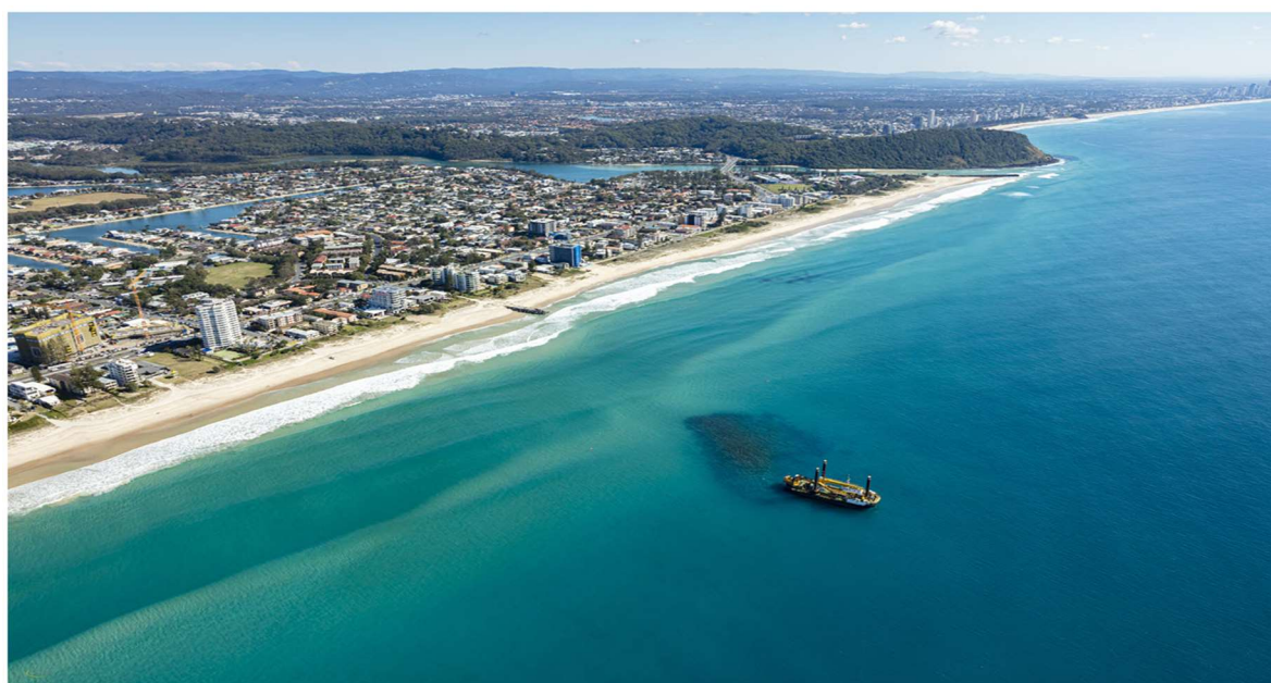
Figura 29.11. Etapa final da construção do quebra-mar de recife ( reef breakwater ) em Palm Beach, Gold Coast, Queensland, Austrália.
