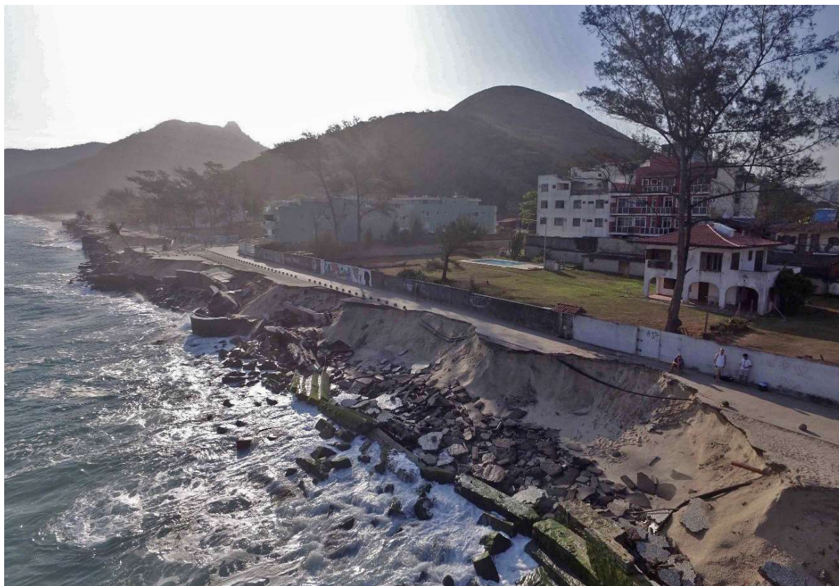
Figura 29.3. Erosão Costeira e destruição de infraestrutura pública e privada em área urbana após tempestade, Praia da Macumba, Rio de Janeiro, RJ. Em 15 anos tal estrutura colapsou ao menos cinco vezes. Fonte: Thiago Pereira, 2017.
