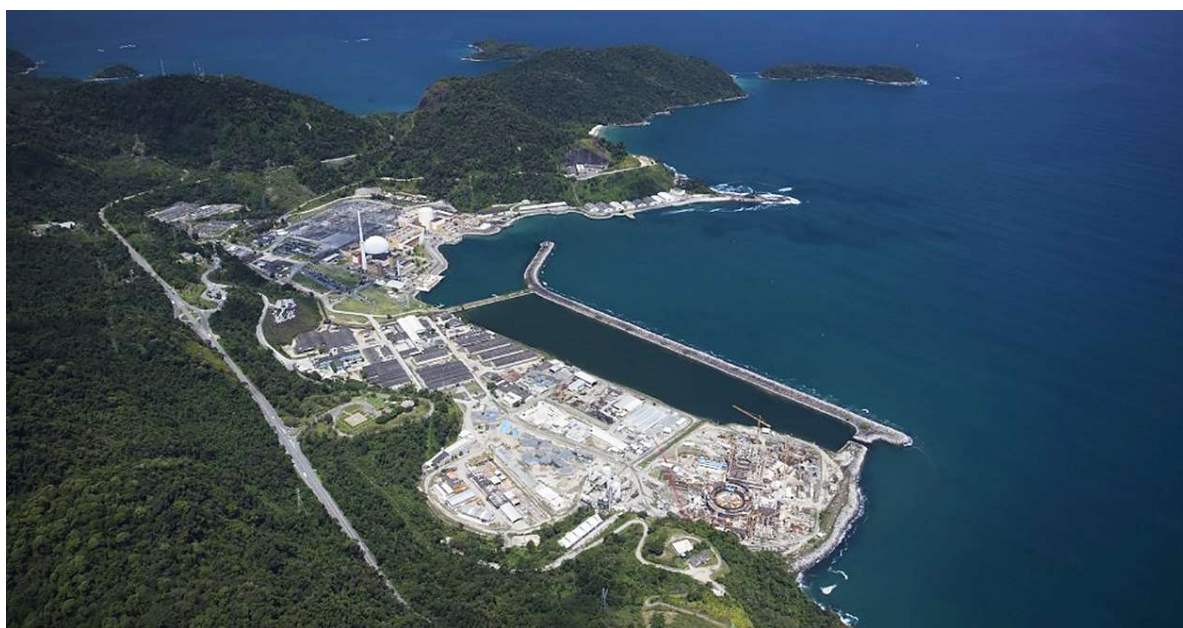
Figura 29.9. Vista aérea do Quebra-Mar que protege a planta industrial da Central Nuclear Almirante Álvaro Alberto, Angra dos Reis, Rio de Janeiro.
