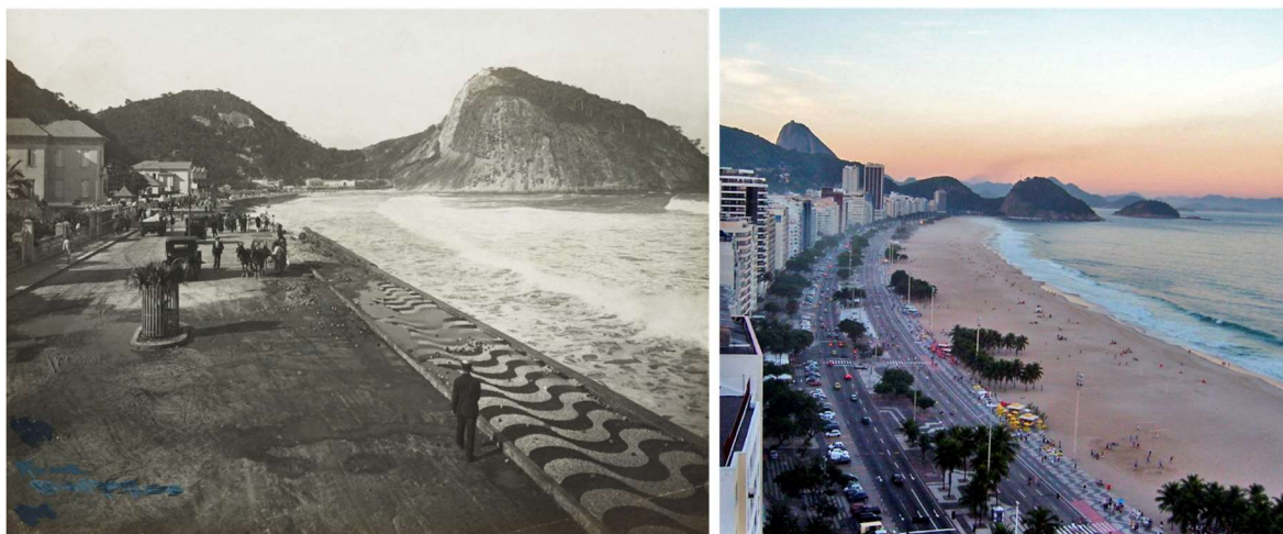
Figura 29.16. Exemplo da praia de Copacabana antes e depois do projeto de alimentação artificial. À esquerda registro de evento com ondas de tempestade na praia de Copacabana, trecho do Leme, ocasionando destruição do calçadão. À direita foto panorâmica do ano de 2006.
