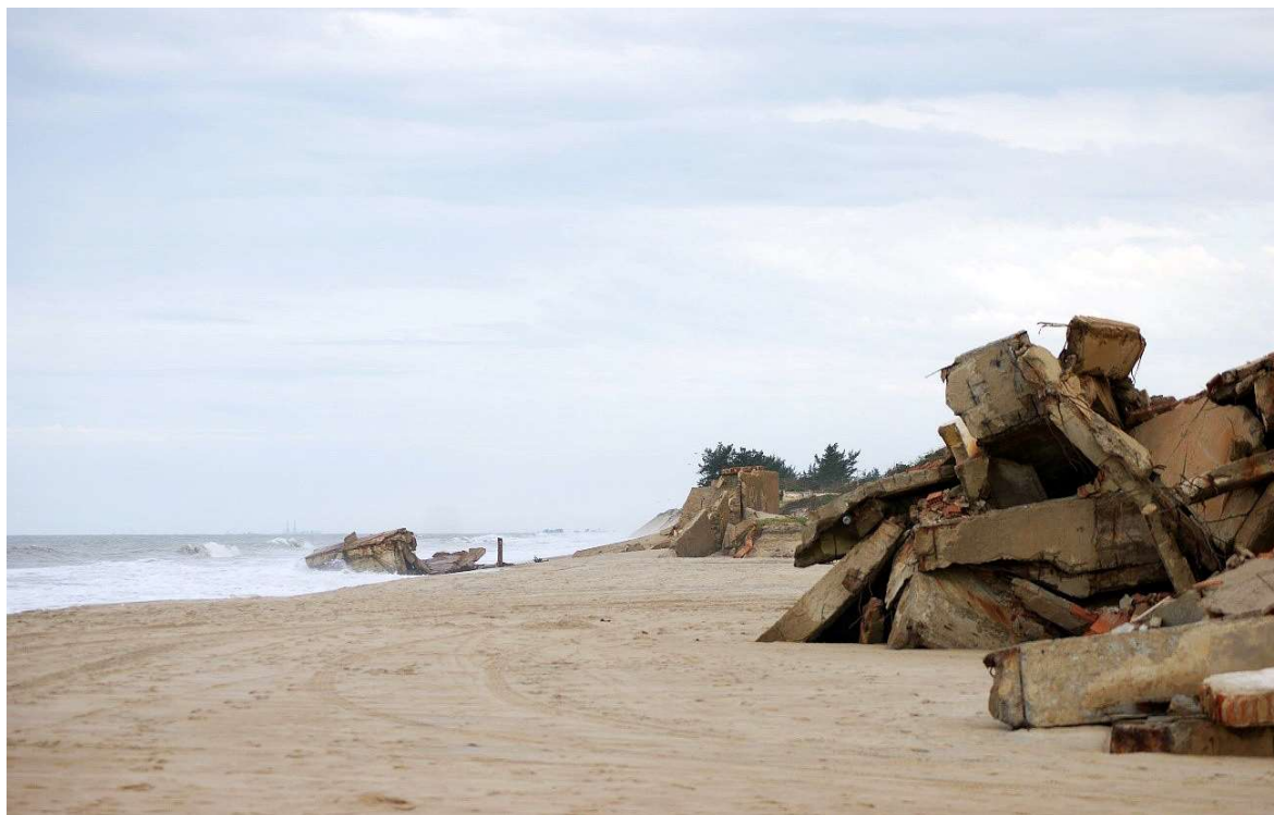
Figura 29.19. Praia de Atafona, São João da Barra, RJ. Cinco décadas de erosão costeira e de estratégia de "fazer nada" resultaram na perda aproximada de 1.000.000 m 2 e mais de 180 residências, ao longo de 14 quarteirões. Para uma revisão sobre o tema ver Bulhões (2018b).
