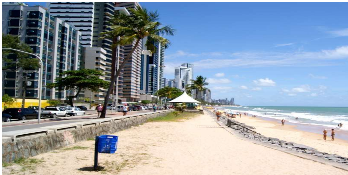
Figura 29.21. Praia de Boa Viagem, Recife, Pernambuco, Brasil. A faixa de areia entre duas estruturas longitudinais de proteção à costa. Soluções híbridas podem ser pensadas e melhoradas mesmo em áreas densamente urbanizadas onde há pouco espaço disponível.
