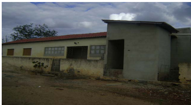
Figura 02: Escola da comunidade Caititu que estava sendo reformada antes da instalação do conflito territorial. Registro realizado em dezembro de 2016.
