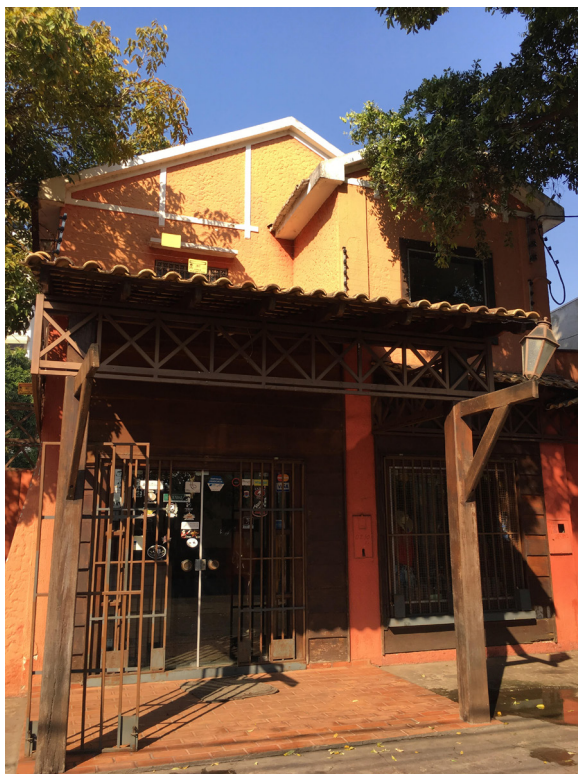
Figura 4 – Antigo sobrado na Avenida Getúlio Vargas Fotografia: Sônia R. Romancini (2018).
