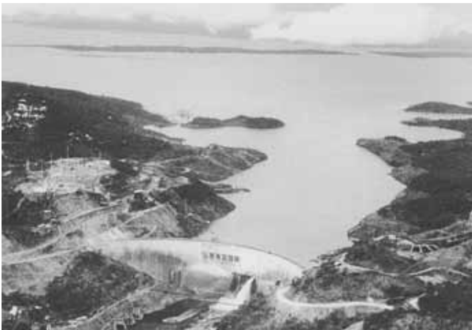
FIGURA 14.6 Em cima: a barragem de Akosombo, em Gana. Em baixo: a grande barragem de Kariba, no Zimbabwe. (Fotos: Newslink Africa, Londres; Topham, Londres.)
