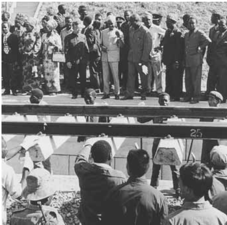
FIGURA 27.3 TAZARA (ou Uhuru), estrada de ferro Tanzânia-Zâmbia, construída com a ajuda dos chineses. Instalação dos trilhos na fronteira entre a Tanzânia e a Zâmbia, em setembro de 1973, com a presença de autoridades chinesas e dos presidentes Julius Nyerere, da Tanzânia, e Kenneth Kaunda, da Zâmbia. (Foto: The Hulton-Deutsch Collection, Londres.)
