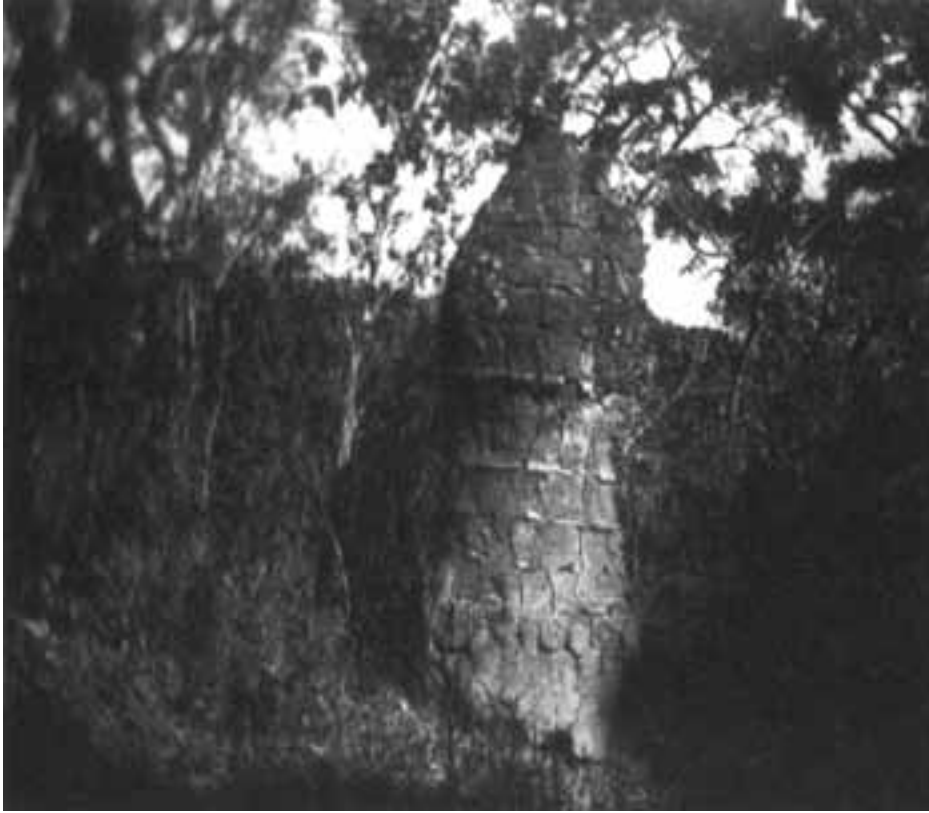
FIGURA 21.7 Restos de um forno para fundir o ferro (ng'anjo) tumbuka. A fama de forjadores dos tubuka só era igualada pela dos Phangwa, na margem leste do Lago Malauí. [© K. M. Phiri.]
