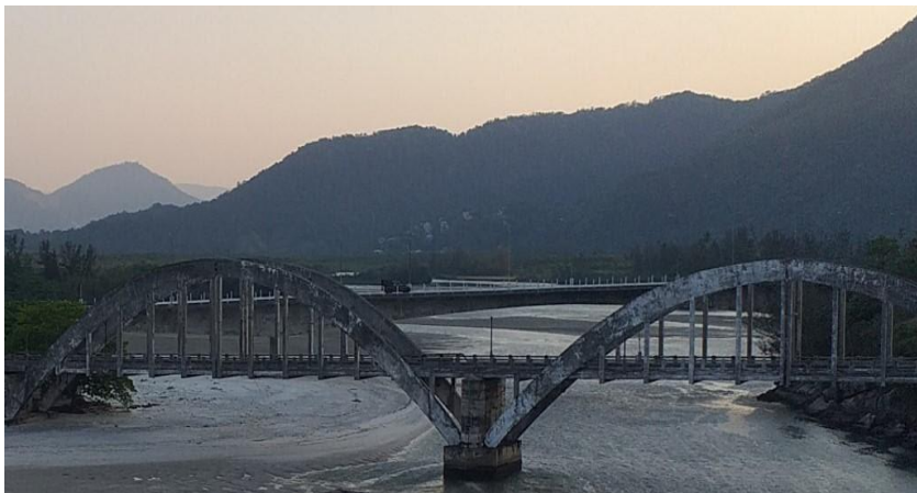
Figura 2 - Ponte Velha, desativada pelo exército, mais ao fundo ponte Nova, com acesso restrito a militares.
