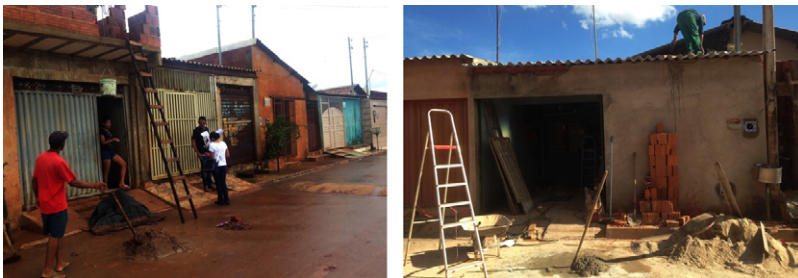
Figura 5 – Vila Estrutural – reformas feitas pelos moradores
