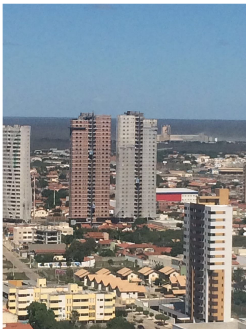
Figura 08: Prédios em construção.
