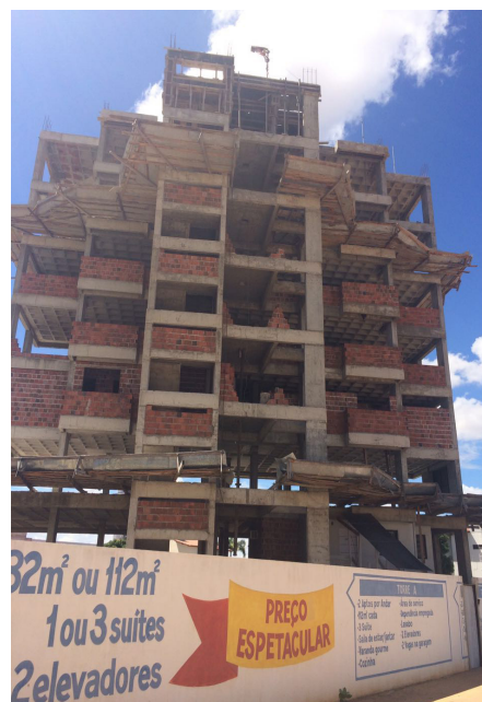
Figura 09: Prédios em construção.
