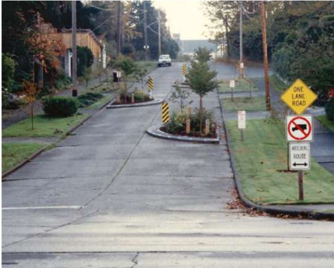
Figura 8 – Medidas Moderadoras de Tráfego: Chicanas (Deflexão horizontal)
