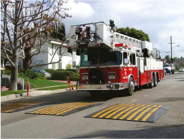
Figura 7 – Medidas Moderadoras de Tráfego: Almofadas (Deflexão vertical)
