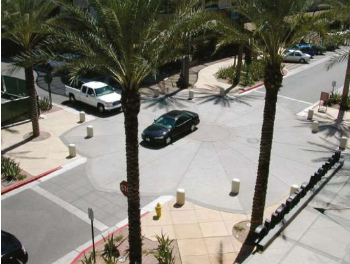
Figura 6 – Medidas Moderadoras de Tráfego: Platôs (Deflexão vertical)
