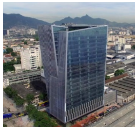
Edifício Vista Guanabara
