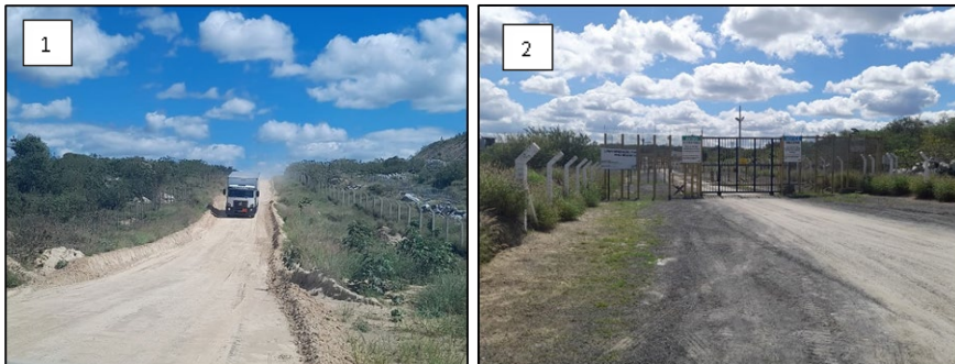
Figuras 1 e 2: Trânsito de caminhões e parte da cerca com portão de entrada da Mina Braúna, 2023
