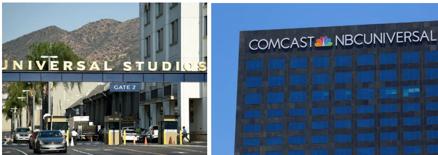
Figura 2 - Edifício administrativo (à esquerda) e complexo de estúdios (à direita) da Comcast NBCUniversal (Estados Unidos).
