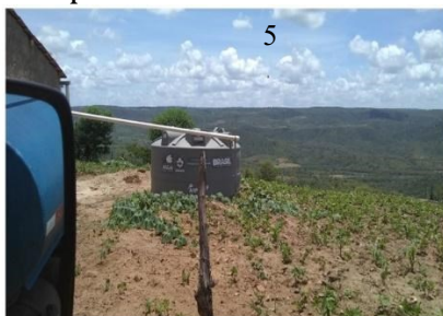
Cisterna de polietileno
