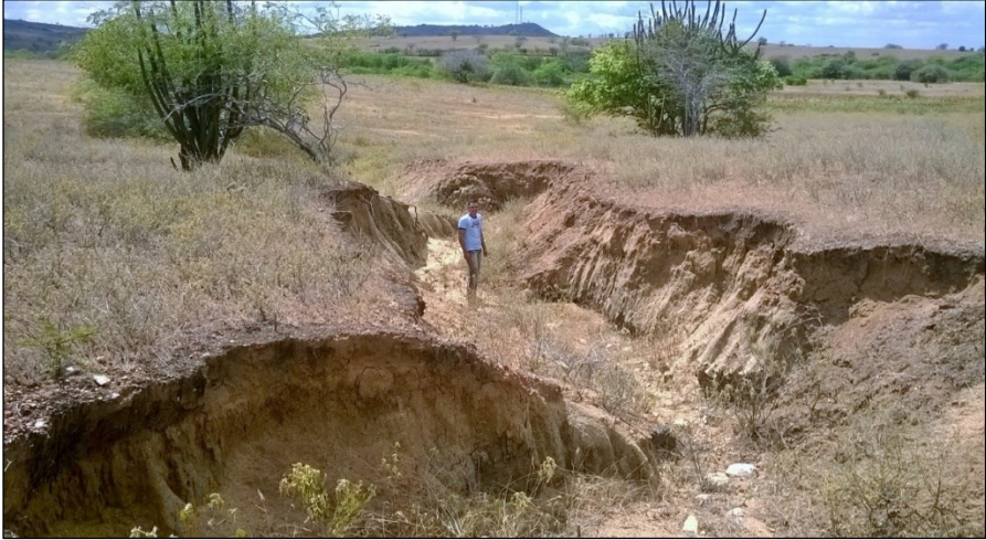
Figura 4 - Erosão em Voçorocas no Sítio Marcação/RN.
