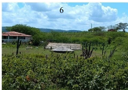
Cisterna de placa-Calçadão
