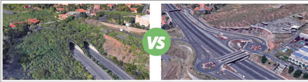
Figura 22.12. Tratamiento de IV en los túneles de GC y aspecto actual de la TF a la altura del municipio de Candelaria
