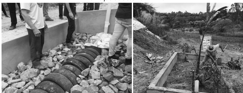
Figura 4 – Construção do Tanque de Evapotranspiração (TEVAP) na propriedade do Sr. Vicente, em Cachoeira de Almas - Florestal - Minas Gerais: a) processo de construção; e b) finalização do sistema TEVAP.
