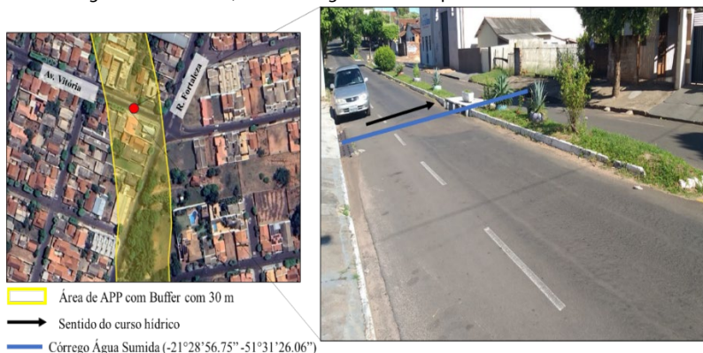
Figura 6 - Av. Vitória, local de alagamentos em período de chuvas fortes.
