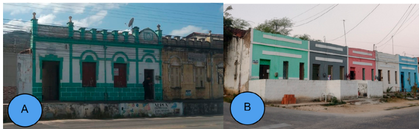
Figura 1– Casas localizadas no bairro Outra Banda
