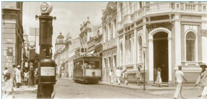
Figura 2 – Bondes elétricos em Fortaleza (1930)
