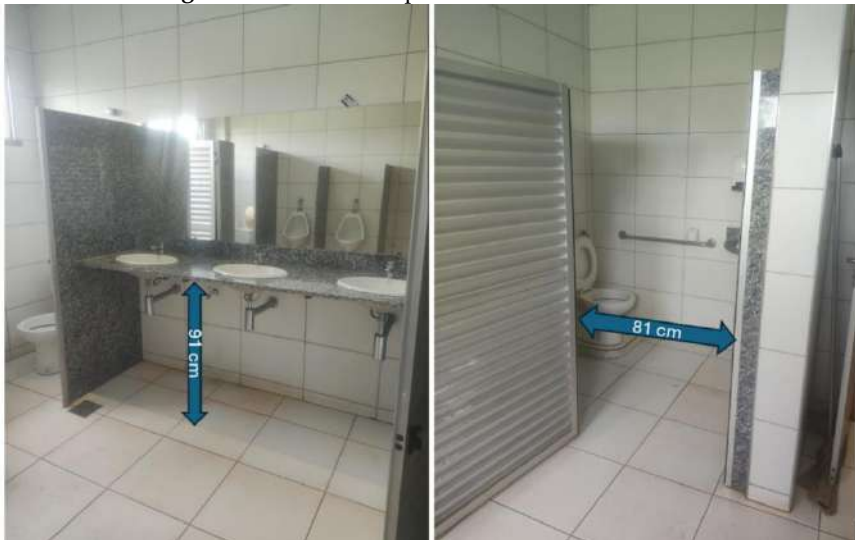
Figura 3: Pia comum e porta banheiro acessível RU
