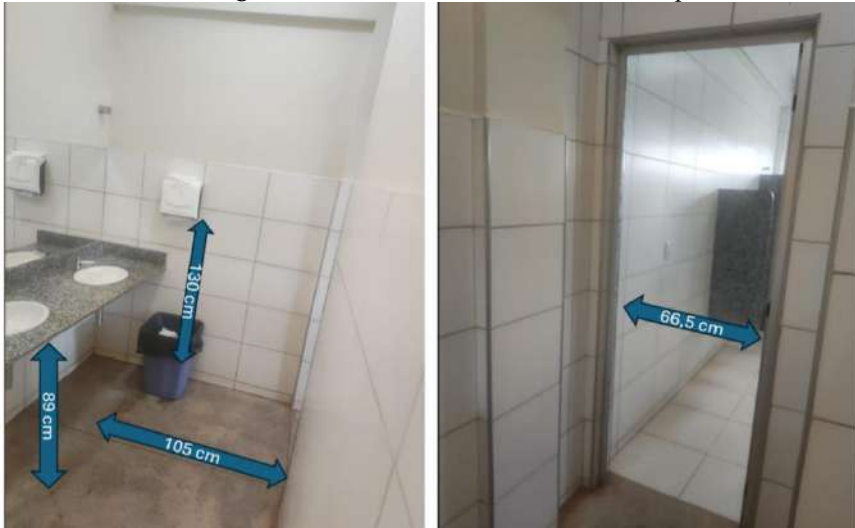
Figura 2: Corredor entrada banheiros RU e pia
