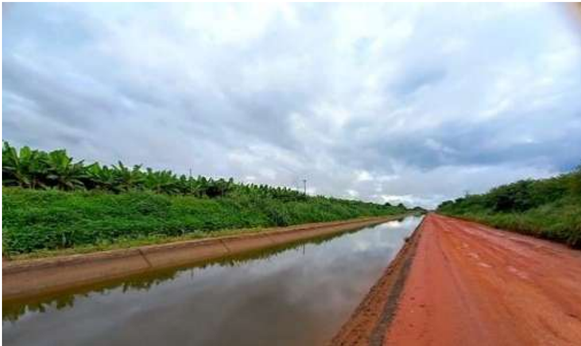
Foto 2 – Infraestrutura hidráulica do Projeto Público de Irrigação Formoso
