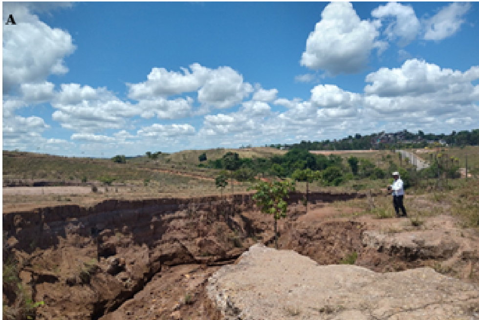
FIGURA 3A – Voçorocamento na unidade NVdf no Cabo de Santo Agostinho – PE.
