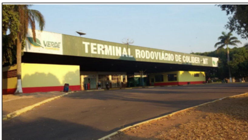
Figura 4- Terminal Rodoviário de Colíder, Mato Grosso
