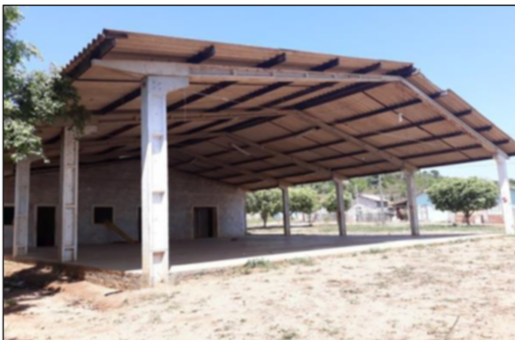
Figura 5 - Pavilhão comunitário, utilizado como ponto de ônibus escolar, Conjunto habitação João Paulo II, Terra Nova do Norte, Mato Grosso.
